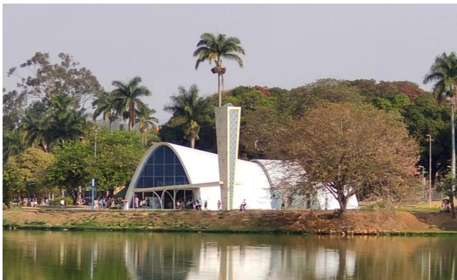
Figura 04. Igreja São Francisco de Assis da Pampulha, Belo Horizonte, Brasil. Fonte: Foto do autor.
