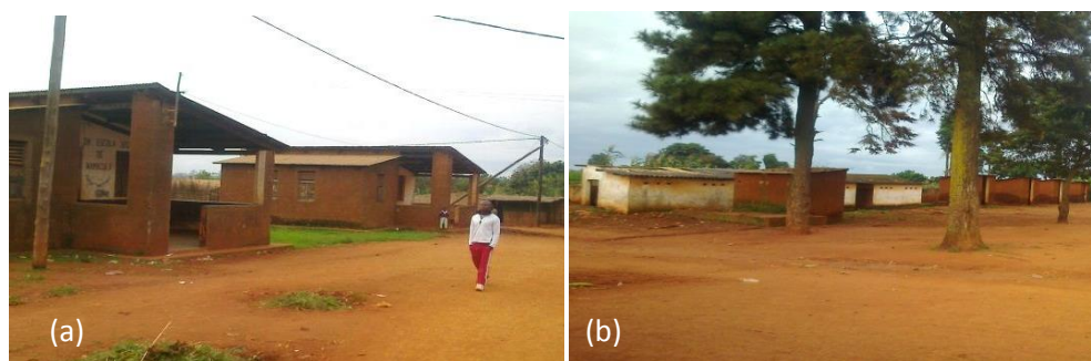
Figura 2. (a) Residências da Direcção e (b) Casas de banho da Escola.
